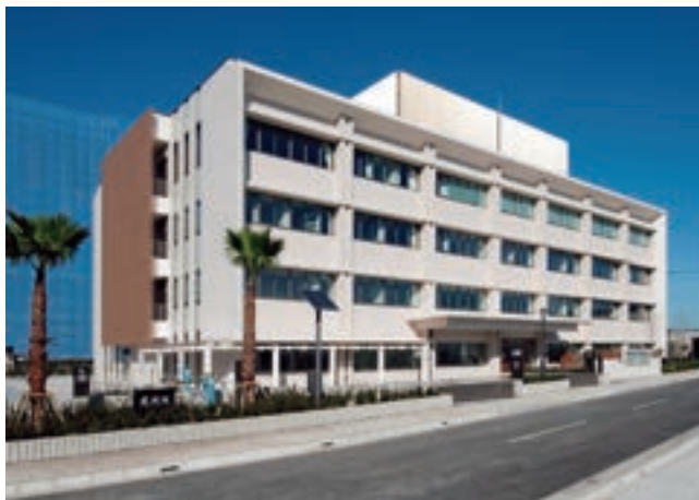
横浜地家裁横須賀支部庁舎新営建築（神奈川県横須賀市）
