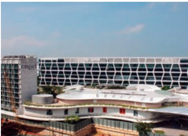
チャンギビジネスパークホテル棟・オフィス棟新築（シンガポール）
