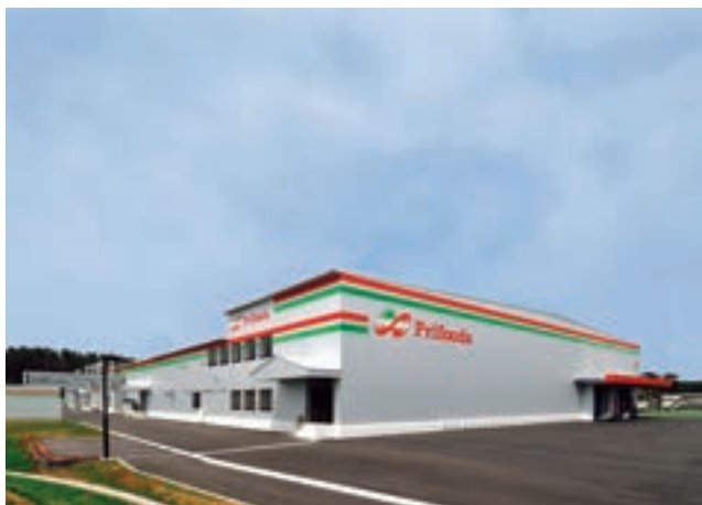
プライフーズ株式会社三沢みどりの郷工場建設 (青森県三沢市)
