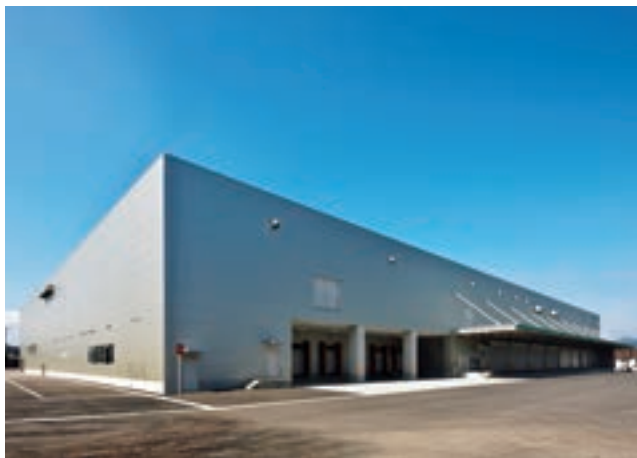
東北地方原料本部事務所等新築 (岩手県盛岡市)
