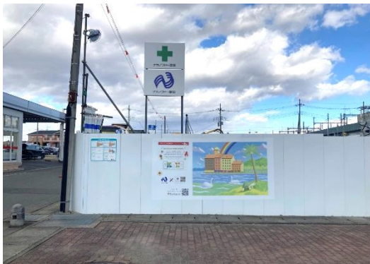
（仮称）那須塩原駅前ビル新築工事
